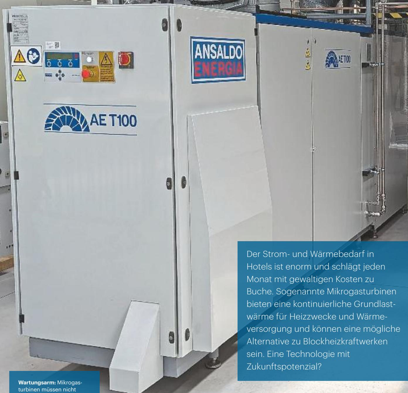
Der Strom- und Wärmebedarf in Hotels ist enorm und schlägt jeden Monat mit gewaltigen Kosten zu Buche. Sogenannte Mikrogasturbinen bieten eine kontinuierliche Grundlastwärme für Heizzwecke und Wärmeversorgung und können eine mögliche Alternative zu Blockheizkraftwerken sein. Eine Technologie mit Zukunftspotenzial?
